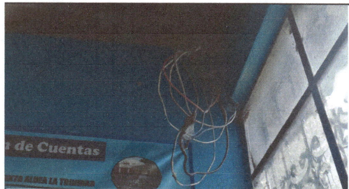
Foto 4: cambio de cableado electrico
