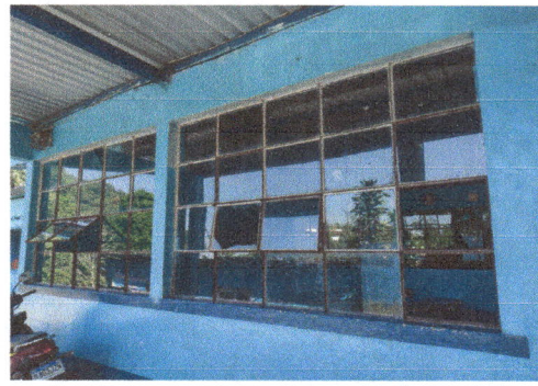
Foto 6: Colocación de balcones
