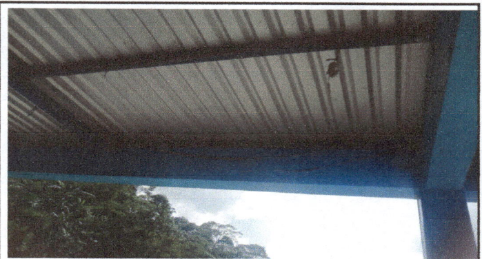
Foto 2: Sustitución de lamparas en los corredores
