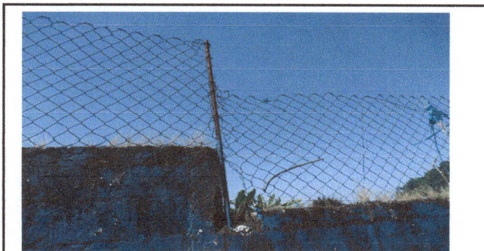
Foto 3: Reparación de enmallado
