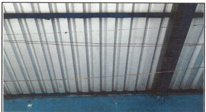
Foto 4: Cambio y entubado de cableado eléctrico
