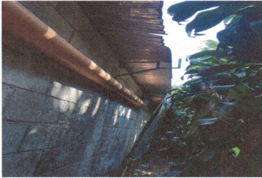
Foto1: Sustrucción de Canal
