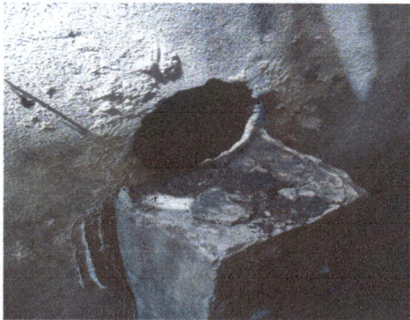
Foto1: reparación de chimenea
