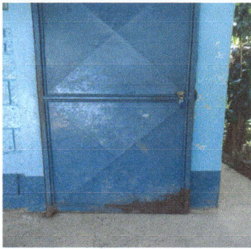
Foto 3: sustitución de puerta
