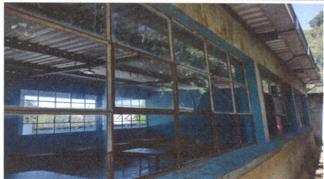
Foto 2: colocación de blacones
