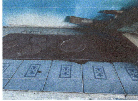
Foto 2: Cambio de planchas de metal de tres ornillas
